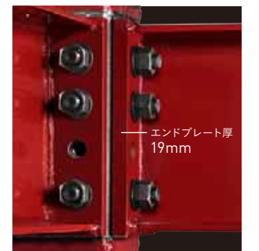
柱-梁接合部/ダイナミックコネクタ
